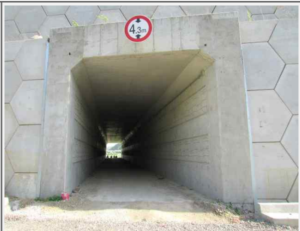
패널식 보강토옹벽 통로박스 전경
