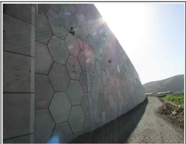
좌측 패널식 보강토옹벽 전면 전경
