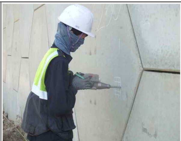
콘크리트 패널 반발경도조사
