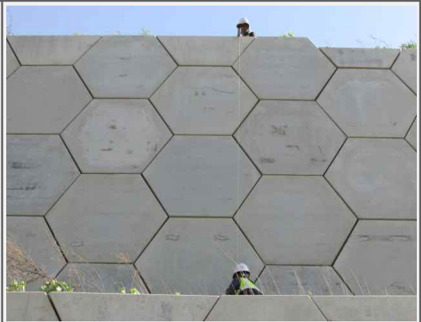
우측 패널식 보강토옹벽 2단 기울기 측정
