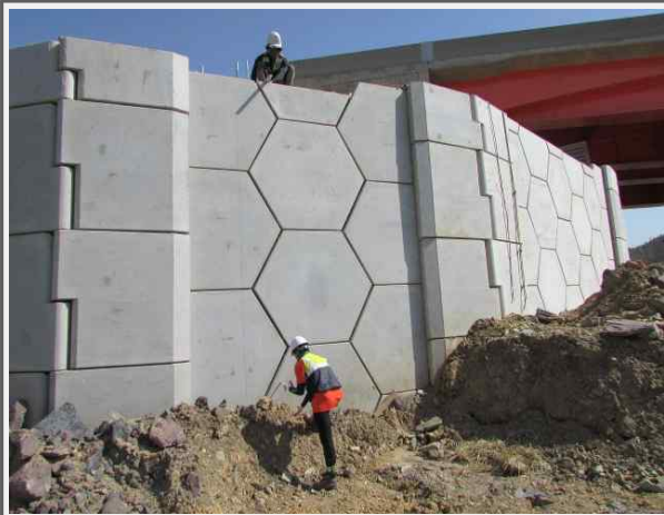
우측 패널식 보강토옹벽 1단 기울기 측정
