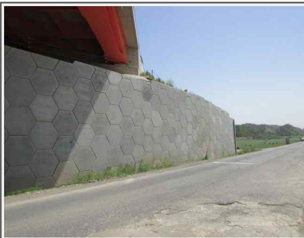
우측 패널식 보강토옹벽 전면 전경
