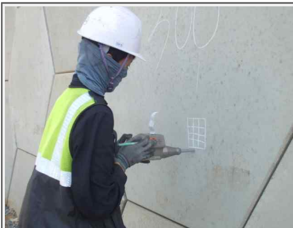
콘크리트 패널 반발경도조사
