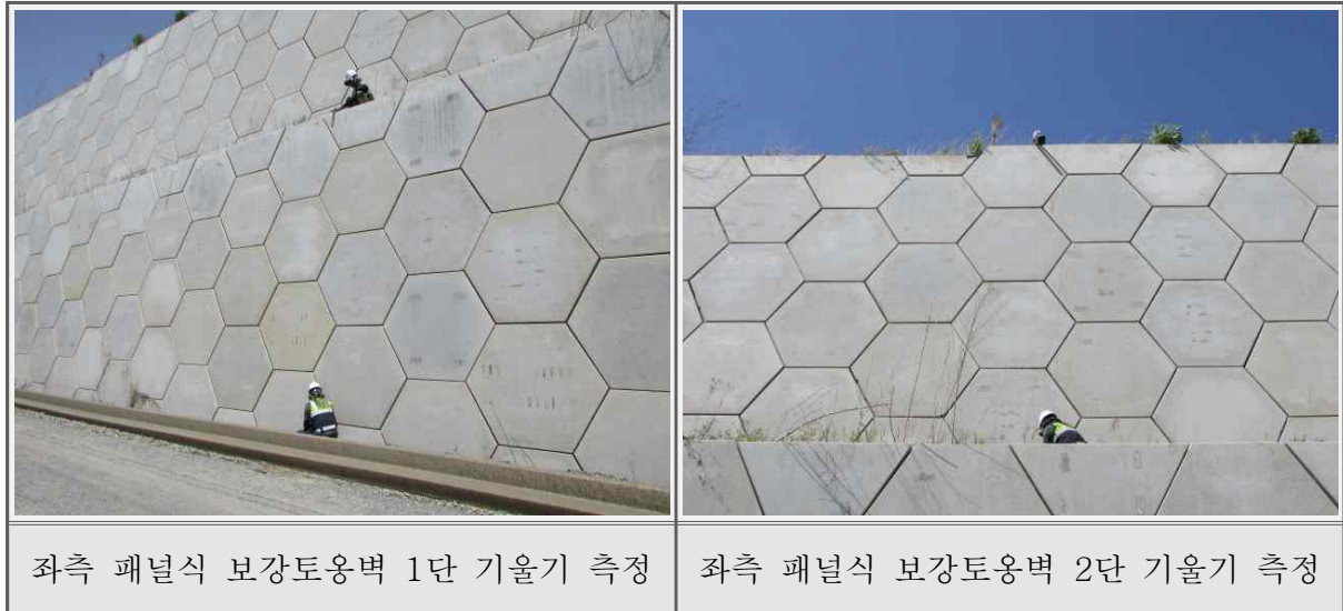
【표 2.2.1】 좌측 패널식 보강토옹벽 기울기 측정 결과
